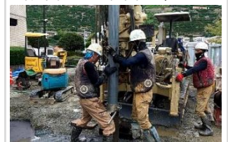
<ケーシングパイプ 挿入工事> 出所：八幡浜市提供
