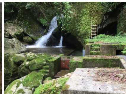
<左：馬路村小水力発電所> <右：取水口>
