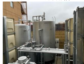
<太陽熱蓄熱層とヒートポンプの貯湯槽>
