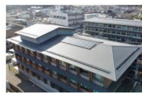
< 太陽光発電設備（本庁舎） >
